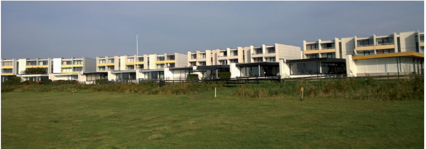
Blick über die Wiesenfläche an den Bungalows nach Norden, 2020
